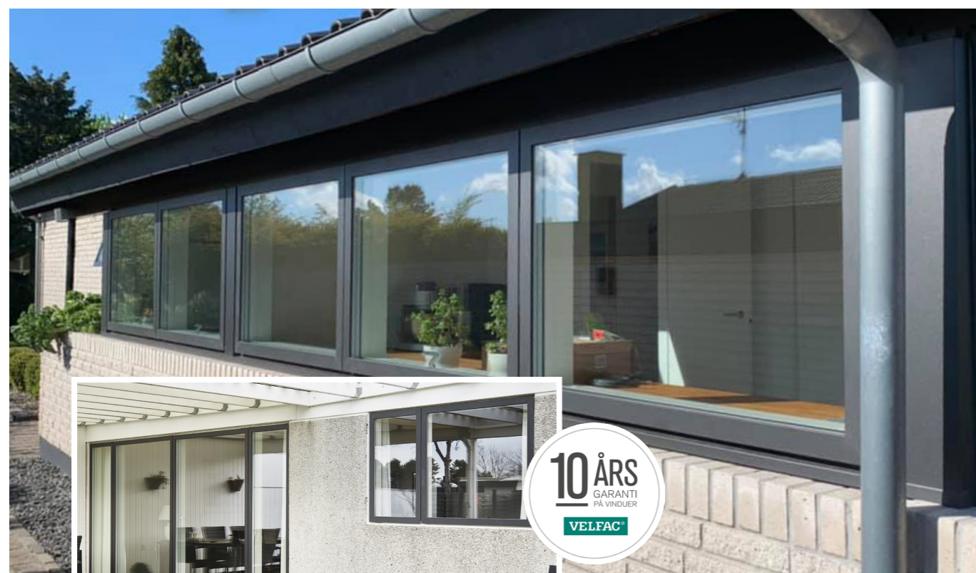
Ny facade med VELFAC 200 Energy.
